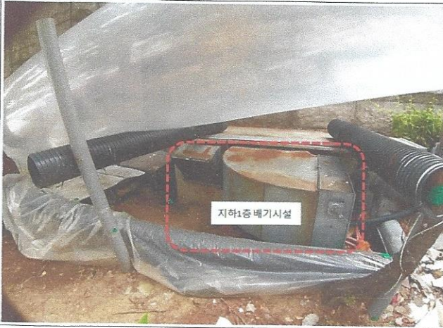
지하1층 배기시설용 노출 구조물
