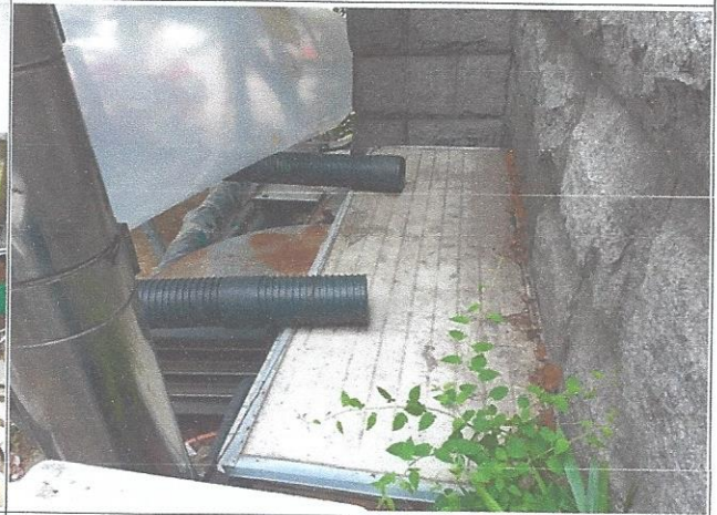
지하1층 배기시설용 노출 구조물 상부
